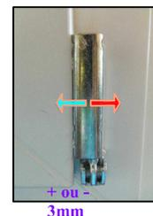
**2** Réglage de hauteur, à l'aide de la clé Allen n°4. (Vantail en position fermé).
