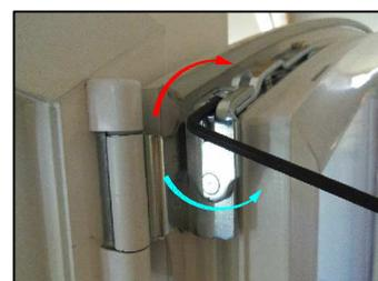
3 \* Réglage de la compression des joints
