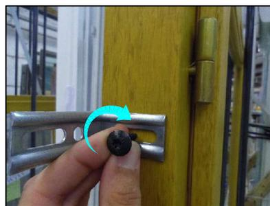
Placer la vis de 30 au milieu du trou oblong (pour garder une possibilité de réglage) puis visser avec un embout *Torx*.
